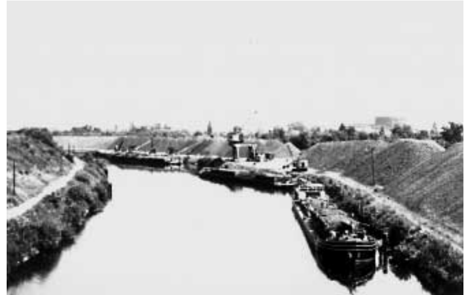
Baustoffumschlag im Hafen Lankwitz, im Hintergrund das Gaswerk Mariendorf, Foto am 1. Juli 1953
